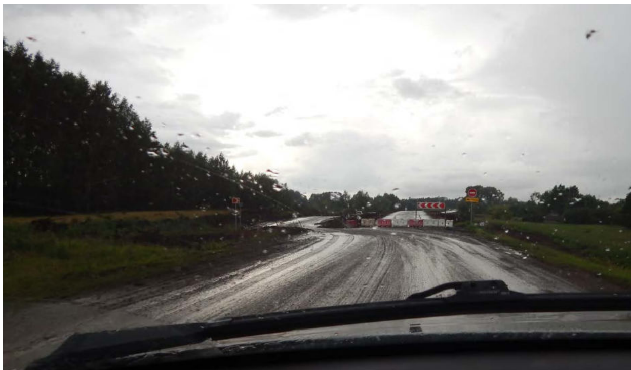
Фото 01.13. Проходим участок ремонта дороги
