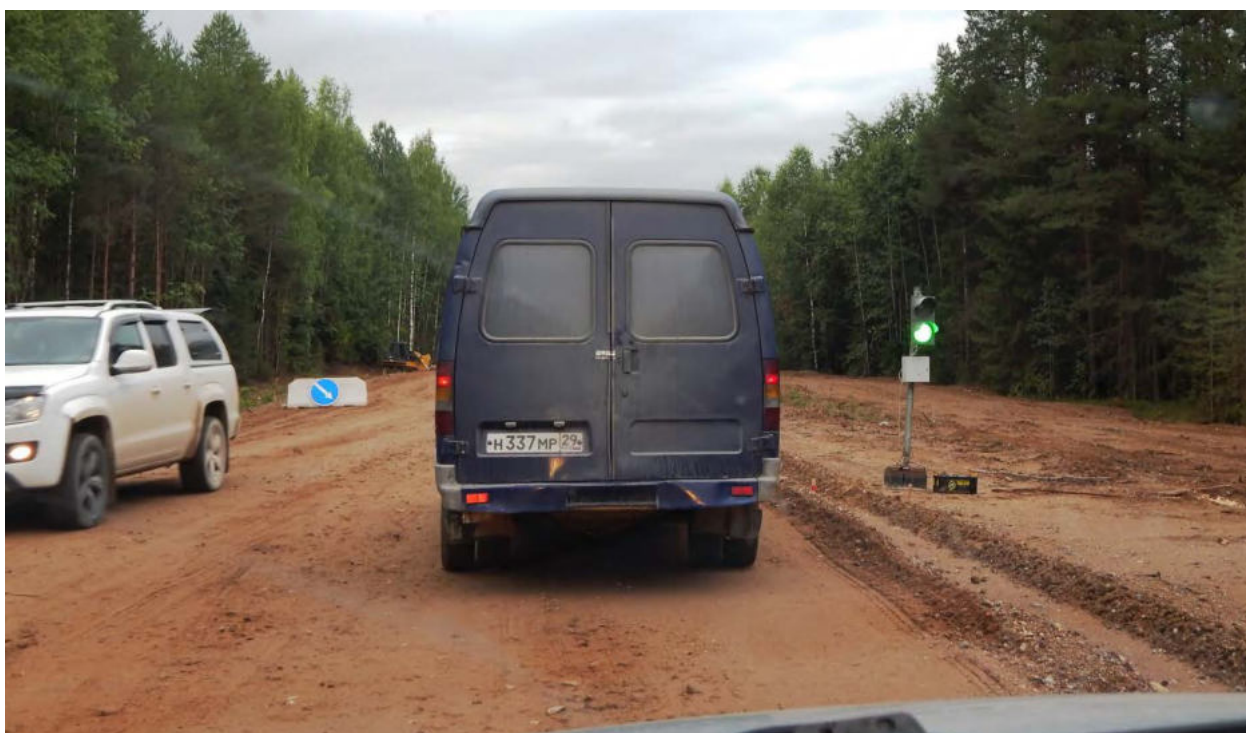
Фото 03.44. Светофор, значит, впереди – ремонт на особо узком участке
