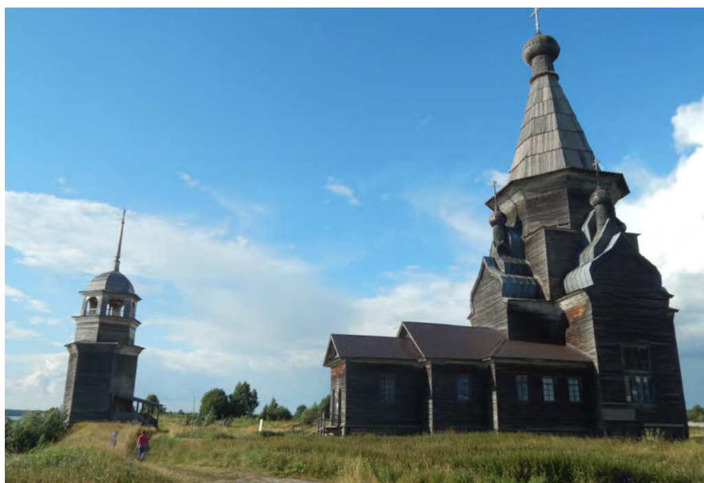
Фото 08.45. Светлана попыталась войти в церковь, но она закрыта на ремонт
