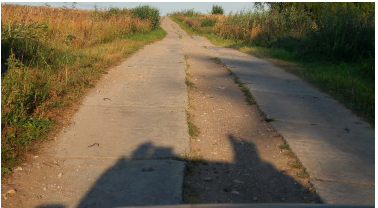
Фото 04.38. Проходим участок «бетонки»
