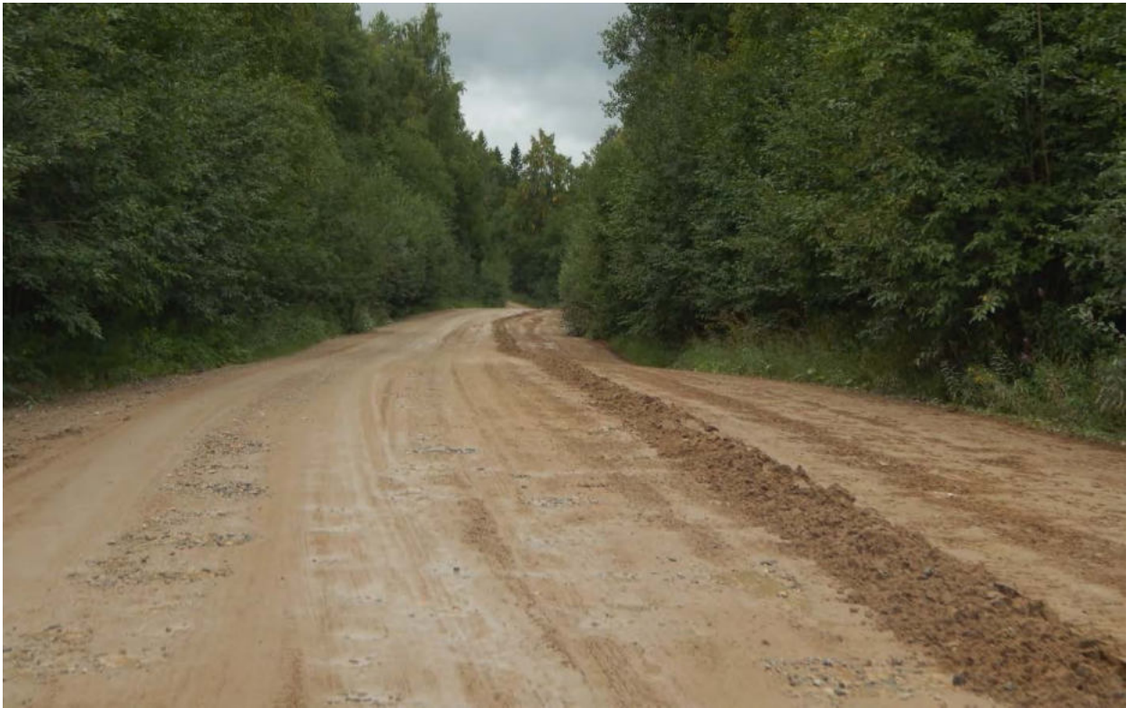
Фото 10.08. Трактор-грейдер нагреб полосу глины
