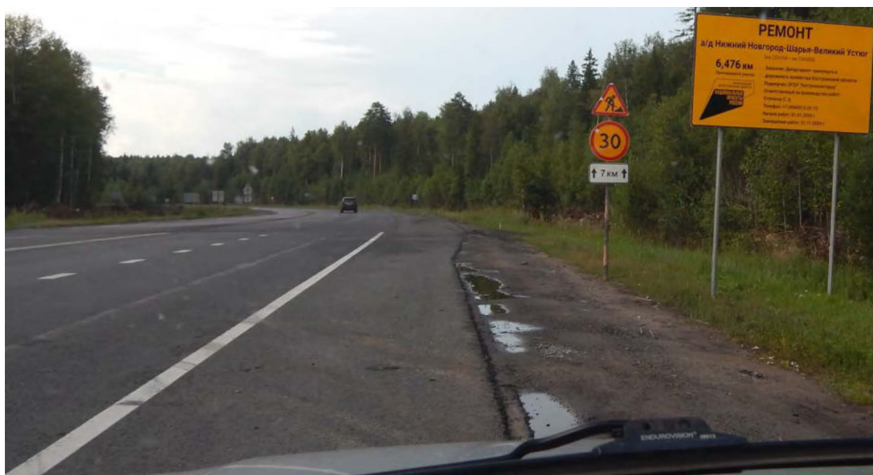
Фото 02.47. Идем на г. Великий Устюг. Начинается участок ремонта дороги
