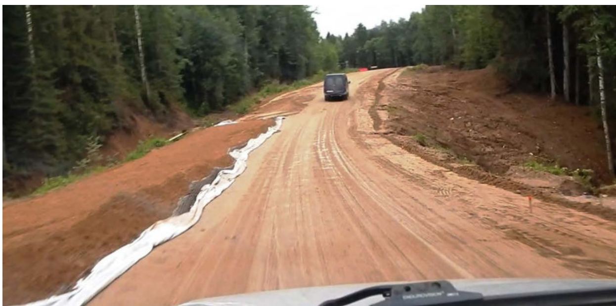
Фото 03.48. Слева – две подложки и насыпь, справа впереди - промоина
