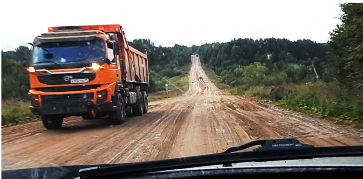
Фото 03.46. Дорогу расширяют, но и разбивают одновременно тяжелыми грузовиками с глиной
