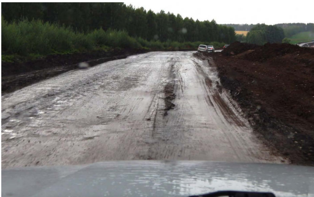
Фото 01.14. Ливень, ремонт, грязь...
