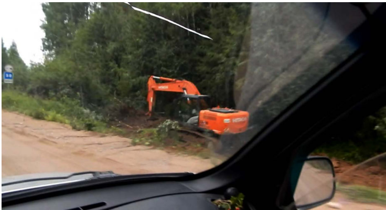
Фото 03.43. Экскаватор «врукопашную» выкорчевывает деревья, потом поднимает грунт наверх
